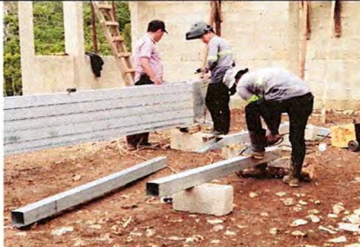
foto 1. Se dio inicio la soldadura de las costanera del entechado de la escuela de parvulo.
