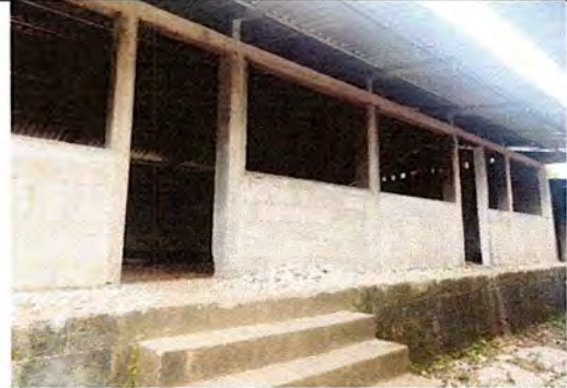
foto 2. Techo de la escuela de parvulo ya esta instalado.
