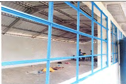
foto 5. Instalacion de ventana con vidrio de la escuela de parvulo.
