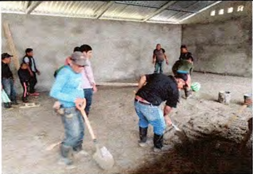
foto 3. Colocacion de piso de torta dentro del salon de parvulo.
