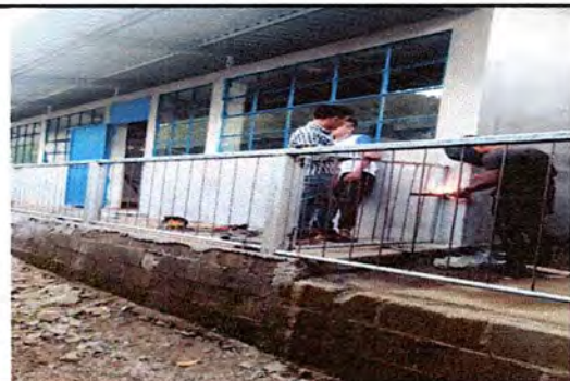
foto 6. Colocacion de barrandas dentro del corredor de la escuela de parvulo.
